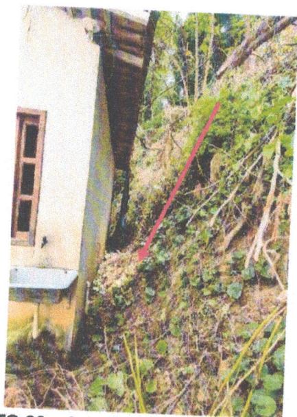
FOTO 06 – Soterramento dos fundos do imóvel onde funciona o Conselho Tutelar
