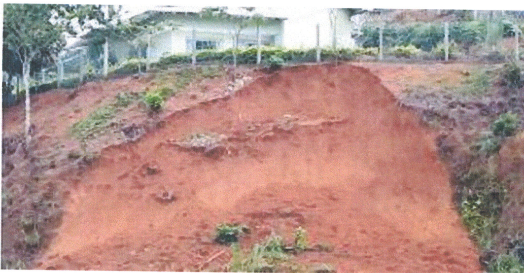
FIGURA 01 - Desmoronamento de encosta.
