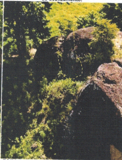
FOTO 04 (DRONE) – Vista da parte posterior do bloco vistoriado onde se visualiza no polígono amarelo tracejado a existência de outro bloco muito próximo ao bloco vistoriado.
