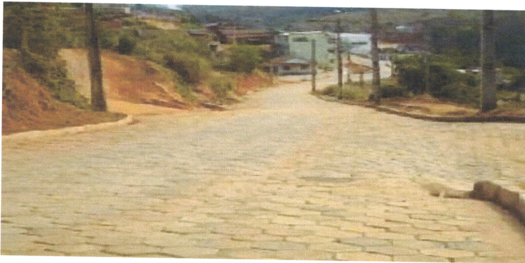
FIGURA 02 – Rua bairro João Paulo II
