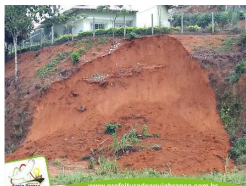
Figura 3-13 - Deslizamento de terra ocorrido com a enchente de 2013 em Águia Branca.
